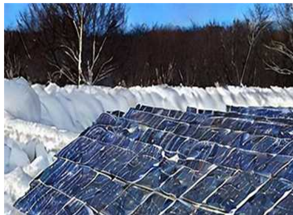
[図1] 氷雪による太陽光発電設備の破損イメージ*
