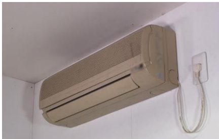
写真1. 内部に洗浄液がかかりトラッキング現象で発火
